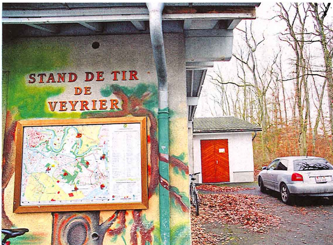
Le promoteur Abdallah Chatila aimerait enterrer le stand et construire des immeubles par-dessus. DR
